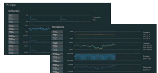
Visualisation des tendances pour chaque équipement surveillé (tension / intensité / facteur de puissance / énergie / demande / puissance apparente / puissance réactive, etc.)
